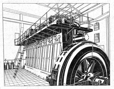
Cia. Sevillana de Electricidad, Sevilla (Espagne). Installation d'un Moteur Diesel ,, S. L. M. - Winterthur" de 3000 Cv., 8 cylindres à 4 temps, à injection mécanique, avec alimentation par turbo-soufflante à gaz d'échappement système Buchi.
