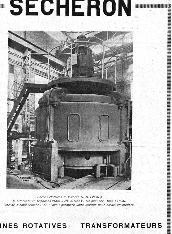
Forces Motrices d'Orsières S. A. (Valais) 2 alternateurs triphasés 7000 kVA, 10500 V, 50 pér/sec., 600 T/min., vitesse d'emballement 1100 T/min.; première unité montée pour essais en ateliers.
