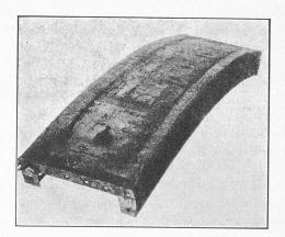
Fig. 13. — Tunnel à Détroit. — Voussoir en acier laminé.
