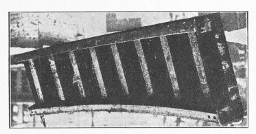
Fig. 14. — Tunnel à Détroit. — Voussoir en acier laminé.
