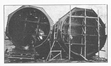
Fig. 4. — Tunnel à Détroit. Vue de deux tubes, l'un étant fermé provisoirement aux deux bouts. Aux extrémités de son diamètre horizontal : oreilles en acier moulé pour la jonction avec le tube suivant. Dans le tube ouvert : raidissage provisoire.
