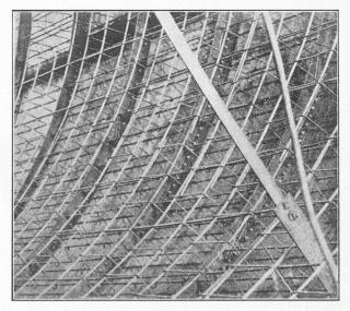
Fig. 6. — Tunnel à Détroit. Armature du revêtement interne, en béton armé.
