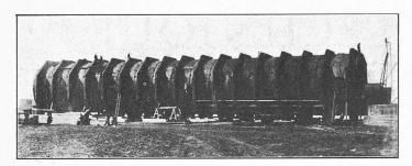
Fig. 2. — Tunnel à Détroit. Vue d'un tronçon de tube en acier laminé.
