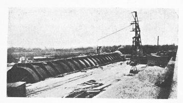
Fig. 7. — Tunnel à Détroit. — Bétonnage intérieur.
