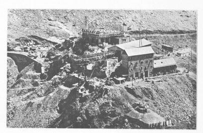
Fig. 5. — Chute de la Dixence : usine à béton et magasins.
