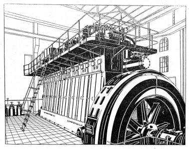
Cia. Sevillana de Electricidad, Sevilla (Espagne). Installation d'un Moteur Diesel "S. L. M. - Winterthur" de 3000 Cv., 8 cylindres à 4 temps, à injection mécanique, avec alimentation par turbo-soufflante, à gaz d'échappement système Buchi. à injection mécanique et par insufflation, pour installations fixes, bateaux et locomotives.
