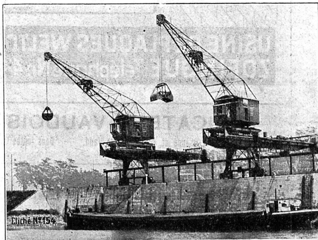
Deux grues de quai dans le nouveau port de Bâle.
