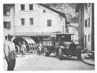
Fig. 31. Transport d'un demi-stator dans les rues de Sembrancher.
