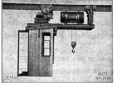
Palan Demag de 5000 kg à translation électrique et avec cabine de conducteur
