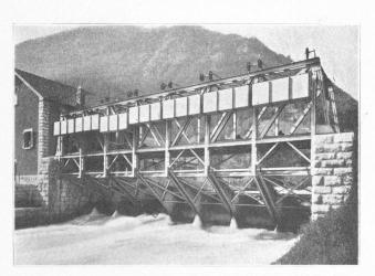
Fig. 2. — Barrage d'Orsières, vu d'aval, montrant les contrepoids.
