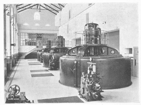
Fig. 9. — Salle des machines. Au fond, la salle de commande, au  $1^{\rm er}$  plan le régulateur et le groupe  ${\rm N^0}$  1.
