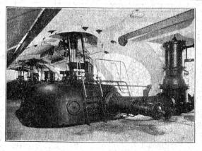
Salle des turbines de l'usine de Sembrancher. 3 Pelton, axe vertical, 2 jets. 5300 ch. — 300 tours : min. — 156 m. de chute.
