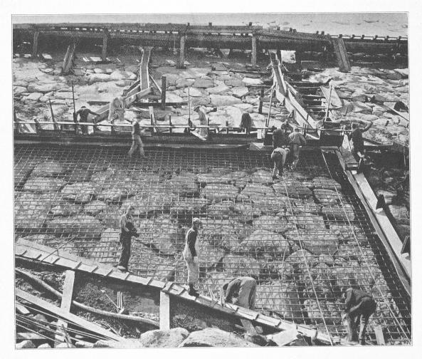
Fig. 10. — Vue de l'armature du masque. Le béton est coulé sur les blocs de rocher mis en place par le derrick. Chaque panneau de  $18,29~\mathrm{m} \times 18,29~\mathrm{m}$  est fait d'une seule coulée.
