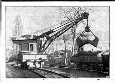
Wildegg Grue pivotante de 3 tonnes, avec benne preneuse de 1,25 m³, alimentée par accumulateurs.
