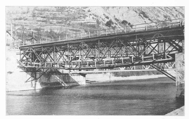
Fig. 3. — Ancien pont encore emprisonné dans la charpente du nouveau pont.
