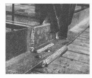
Fig. 5. Joints et nœuds soudés de la membrure inférieure.
