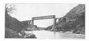
Fig. 26. — Pont militaire sur l'Isonzo, près de Salcano, système Zelisko-Roth-Waagner, portée 90 m monté en porte à faux (1917/18).
