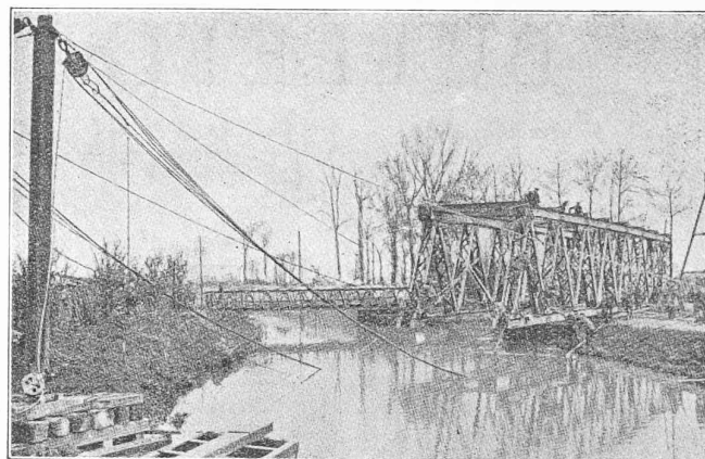
× Fig. 23. — Phase du lancement d'un pont Hopkins, de 36 m de portée.
