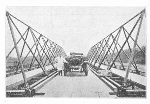
Fig. 21. — Pont système Inglis, composé de deux passerelles et d'un tablier intercalé.
