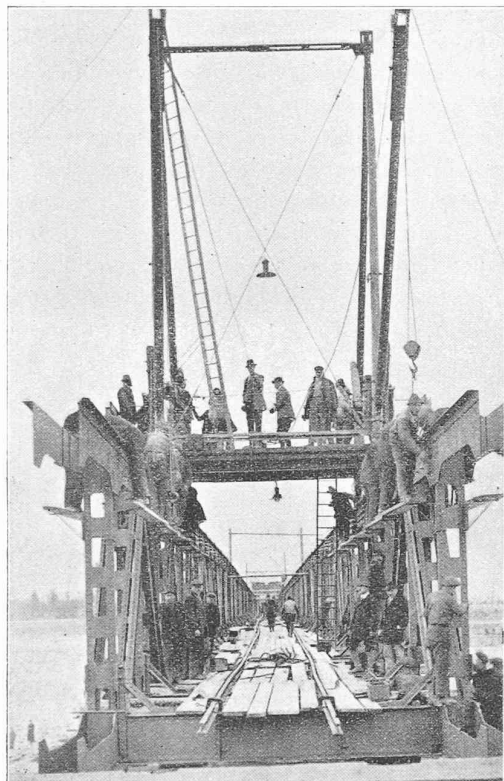
→ Fig. 18a. — Pont système Zelisko-Roth-Wagner, à 4 parois. Montage du pont provisoire près de Buchs (territoire de Lichtenstein).
