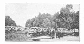
Fig. 19. — Pont système Herbert, montage d'essai.
