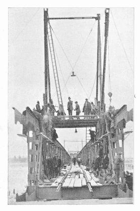
→ Fig. 18a. — Pont système Zelisko-Roth-Waagner,
