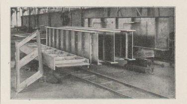
Fig. 1. — Le pont en cours d'exécution, à l'atelier.
