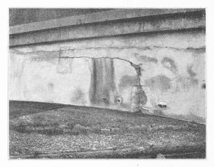
Fig. 2. — Fissure de la voûte.
