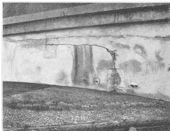
Fig. 2. — Fissure de la voûte.
