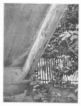
Fig. 14. — Partie d'une passerelle fissurée
