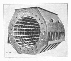
Fig. 21. — Carcasse d'un turbo-alternateur de 45 000 kVA, Brown, Bover & C<sup>1e</sup>.
