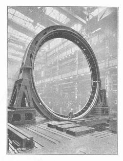
Fig. 15. — Alternateur triphasé de 5000 kVA, Ateliers Siemens-Schuckert.
