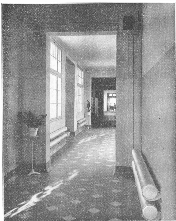
Fig. 3. — Chauffage d'un couloir par radiateur.
