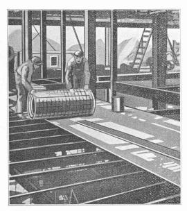
Fig. 17. — Nappe de produit plastique, armé par des lattis métalliques.
