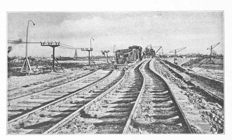
Fig. 2. — Ripeuse déplaçant les voies de l'excavateur.
