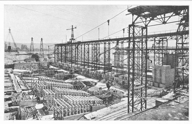
Fig. 4. — USINE HYDRO-ÉLECTRIQUE DE KEMBS Installations de bétonnage du chantier de l'usine.
