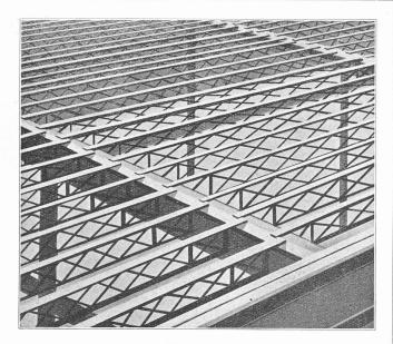
Fig. 9. Squelette d'un plancher composé de poutrelles en treillis.
