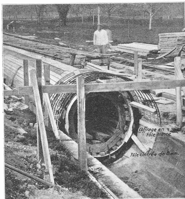
Fig. 18. — Conduite forcée après le décoffrage extérieur. Vue du coffrage intérieur.
