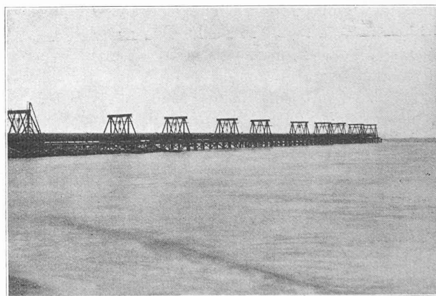
Fig. 21. — La conduite métallique montée sur l'estacade, quelques minutes avant son immersion.
