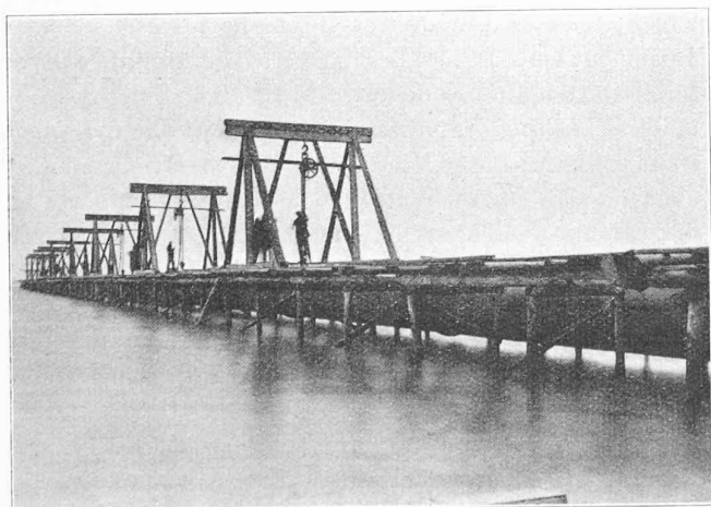
Fig. 22. — Descente de la conduite immergée.
