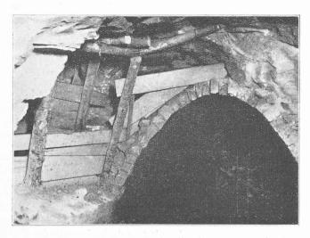
Fig. 9. — Vides formés derrière l'ancienne maçonnerie. Des blocs d'un tiers de m³ s'étaient détachés.
