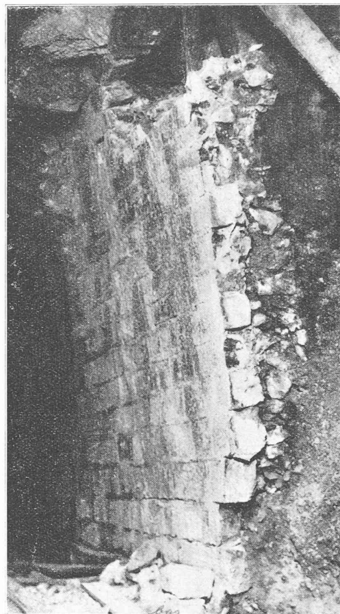
Fig. 10. — Empâtement peu rassurant d'un piédroit de l'ancienne maçonnerie.
