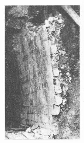
Fig. 10. — Empattement peu rassurant d'un piédroit de l'ancienne maçonnerie.
