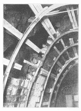
Fig. 7. — Réparation d'une partie de la voûte.
