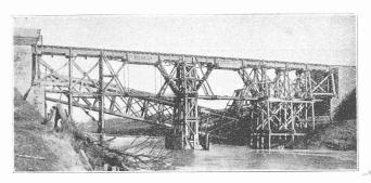
Fig. 33. — Pont près de Keidany, en Lithuanie, pont en bois à côté de l'ouvrage métallique miné.
