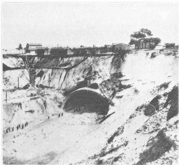
Fig. 29. — Fin 1923. Débouché de la voûte en fond de tranchée, à (+1,50).
