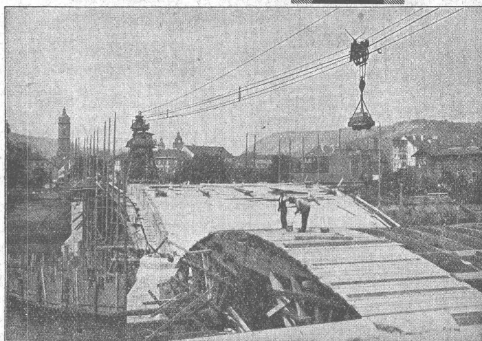
Grue à câble pour la construction d'un pont.
