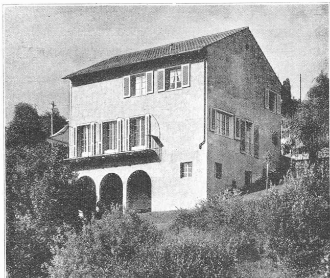
Façade est (dominant le lac) et façade nord.
