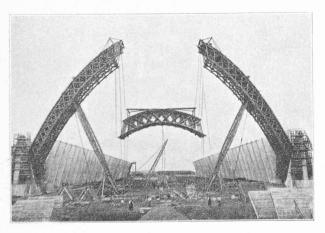
Fig. 7. — Levage de la partie centrale.
