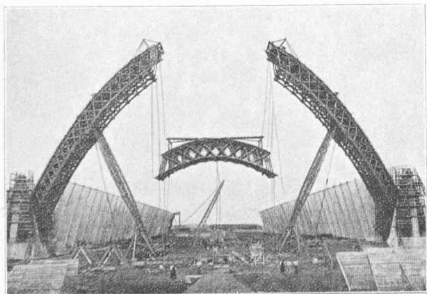
Fig. 7. — Levage de la partie centrale.
