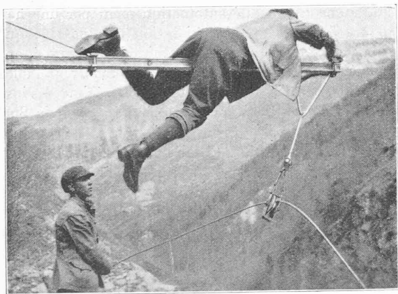
Fig. 22. — Montage de la caténaire.
