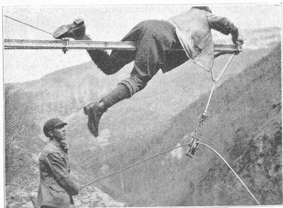
Fig. 22. — Montage de la caténaire.
