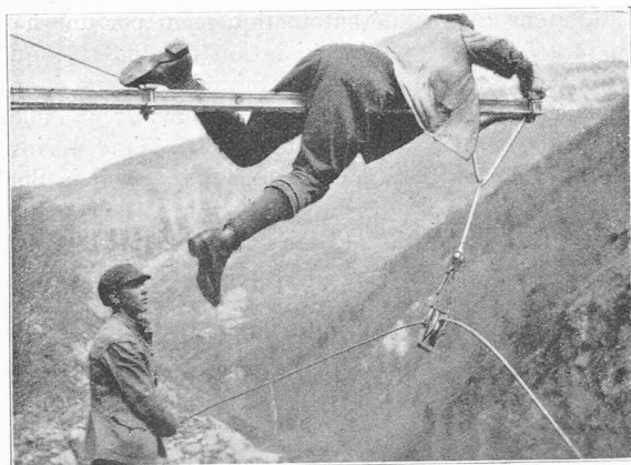
Fig. 22. — Montage de la caténaire.
