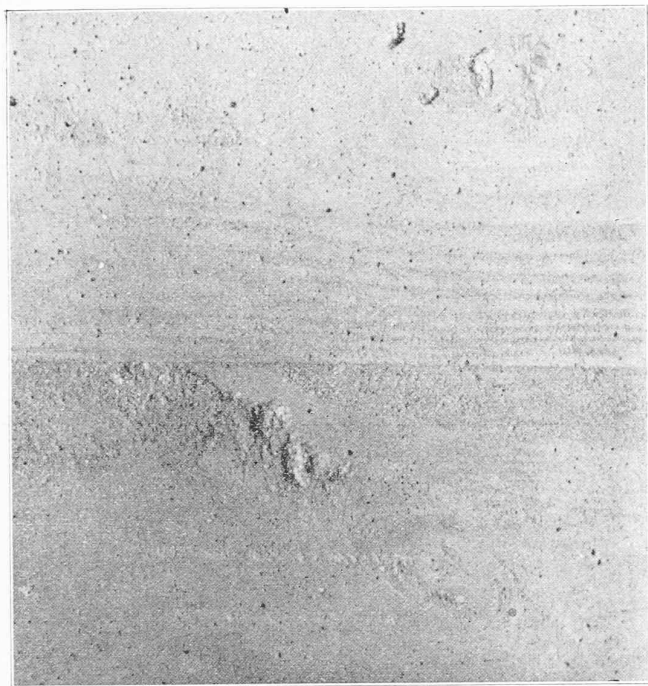
Fig. 7. — Etat d'un béton de ciment alumineux, après 1800 jours d'immersion.
