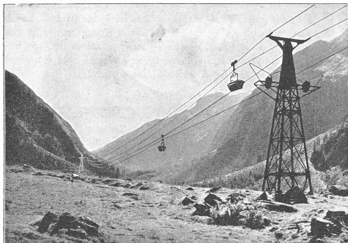
Fig. 2. — Grande portée entre pylônes en fer.
