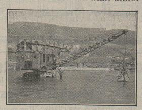
Un Excavateur à grappin « Menck » travaillant et se déplaçant dans une rivière.
