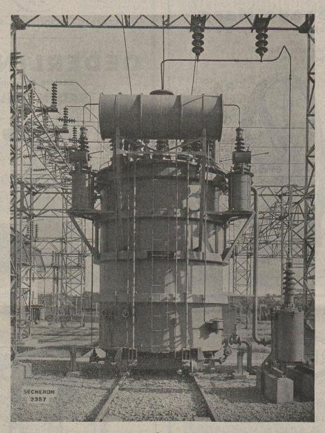
Chemins de fer fédéraux — Station transformatrice de Chiètres 3 Transformateurs monophasés 9000 KVA, 66 à 132 KV, 16 <sup>2</sup>/<sub>3</sub> pér/sec. à refroidissement par circulation d'huile
