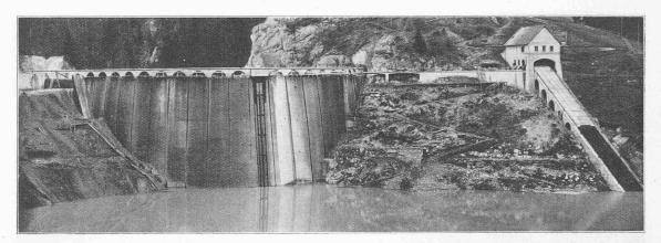
Fig. 13. — Barrage de Montsalvens avec, à droite, la prise d'eau et, à gauche, le déversoir.
