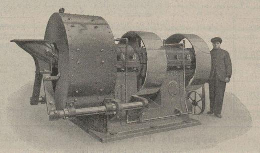
Notre nouveau broyeur à disques pour fabrication du gravillon rendement allant jusqu'à 40 m³ à l'heure.
