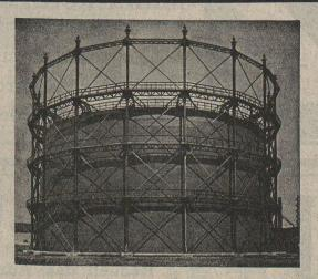
Gazomètre d'une contenance de 50,000 m3.
