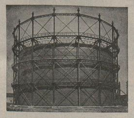
Gazomètre d'une contenance de 50,000 m3.
