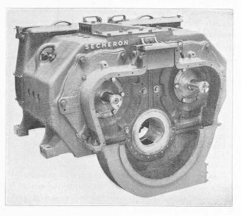
Fig. 1. — Moteur double de 160 ch. pour la locomotive AA-AA à voie étroite du chemin de fer de la Bernina.
