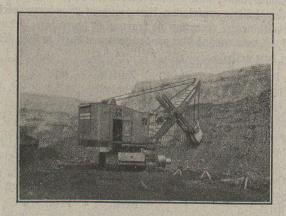
Cette pelle électrique sur chenilles avec godet de 2 m $^3$   $^4$ / $_4$  fait du déblai en donnant un rendement de 1400 m $^3$  mesurés en place dans 9 h. et demi travaillant à un front d'une hauteur d'environ 12 m. dans une matière consistant d'argile et de glaise dure avec une couche de grès d'une épaisseur d'environ 20 cm.
