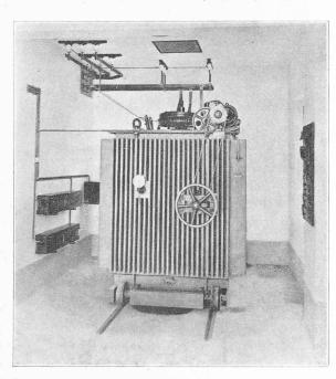
Fig. 15. — Poste de Malapalud. Régulateur d'induction de 4700 kVA.
