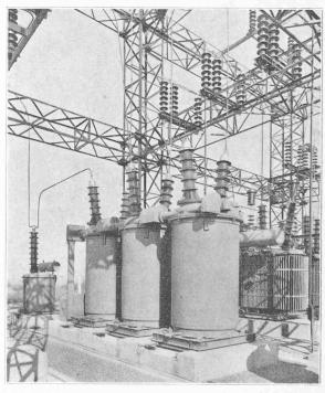
Fig. 17. — Poste de Malapalud. Disjoncteur principal à 120 kV.
