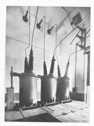
Fig. 10. — Poste de Montcherand. Disjoncteur principal à 120 kV.
