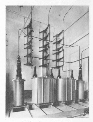
Fig. 11. — Poste de Montcherand. Transformateurs de mesure sur arrivée à 120 kV.
