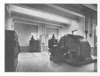
Fig. 9. — Poste de Montcherand. Compensateur synchrone de 5000 kVA, 13,5 kV et régulateurs d'induction à 13,5 kV et 40 kV.
