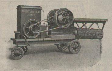
Coût du combustible pour la fabrication d'un m<sup>3</sup> de ballast avec le moteur « Uto » environ 14 centimes au lieu de 54 centimes environ avec moteur à benzine.
