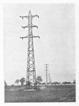
Fig. 4. — Ligne Peuffeyre-Malapalud- Montcherand. Pylone tenseur dans la plaine du Rhône.
