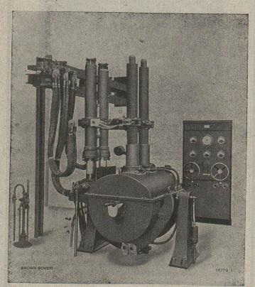
Four électrique à courants triphasés pour la fusion des métaux; réglage des électrodes à main ou automatique, par voie hydraulique; capacité 600 kg. Vue du côté orifice de coulée.
