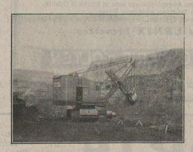
Cette pelle électrique sur chenilles avec godet de 2 m $^3$   $^4$ / $_4$  fait du déblai en donnant un rendement de 1400 m $^3$  mesurés en place dans 9 h. et demi travaillant à un front d'une hauteur d'environ 12 m. dans une matière consistant d'argile et de glaise dure avec une couche de grès d'une épaisseur d'environ 20 cm.
