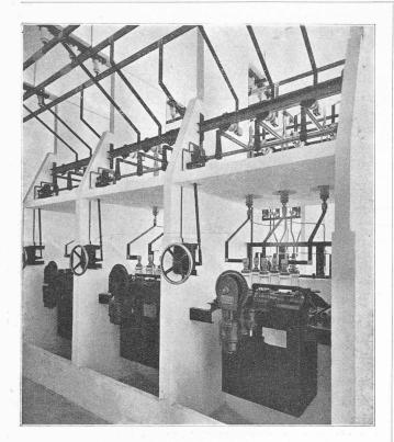
Fig. 26. — Disjoncteurs automatiques des alternateurs.
