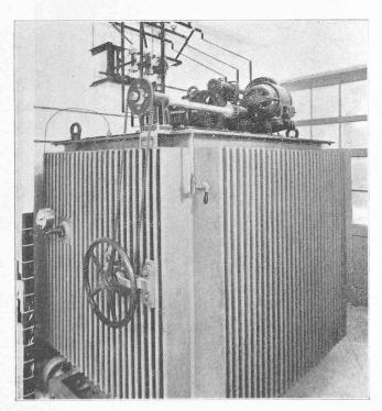
Fig. 24. — Régulateur d'induction, 2000 KVA.
