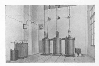
Fig. 30 — Interrupteur à bain d'huile de 120 KV; puissance de déclenchement : 750 000 KVA.
