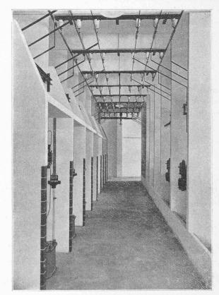
Fig. 23. — Barres collectrices à 5600 volts.
