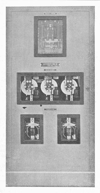
Fig. 21. — Régulateur automatique de tension.
