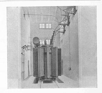
Fig. 29. — Transformateur de 5000 KVA, 5600/60000-120000 volts.
