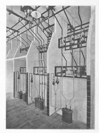
Fig. 27. — Partie de l'appareillage à 5600 volts.
