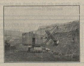
Cette pelle électrique sur chenilles avec godet de 2 m³ <sup>1</sup>/<sub>4</sub> fait du déblai en donnant un rendement de 1400 m³ mesurés en place dans 9 h. et demi travaillant à un front d'une hauteur d'environ 12 m. dans une matière consistant d'argile et de glaise dure avec une couche de grès d'une épaisseur d'environ 2 mètres.
